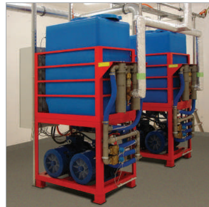
SEM-SAFE®泵浦設備 100%冗餘性
